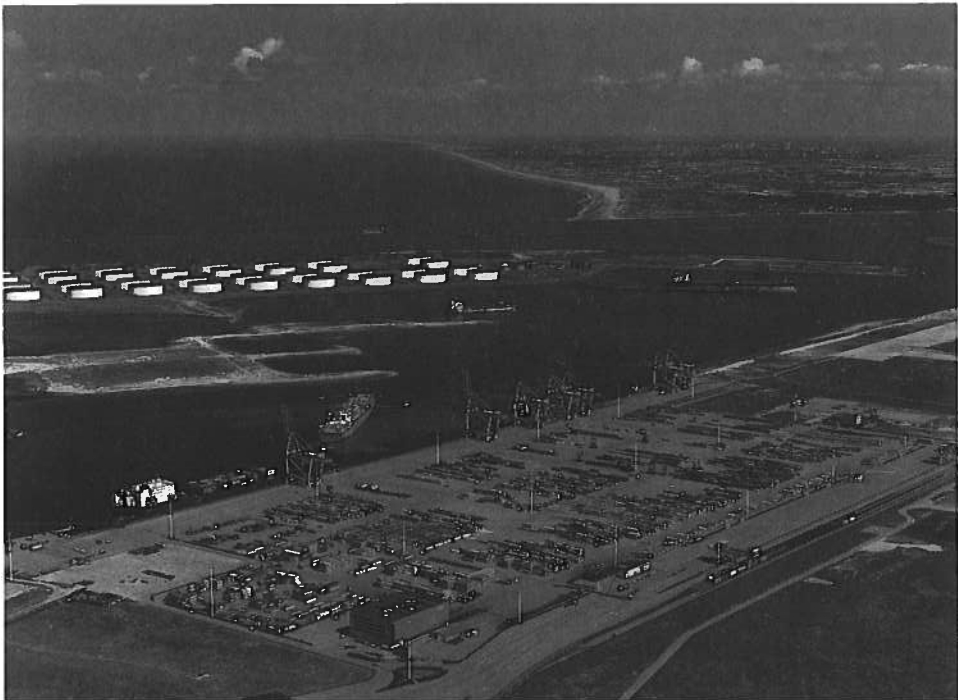
Luchtfoto Delta 1 Terminal
